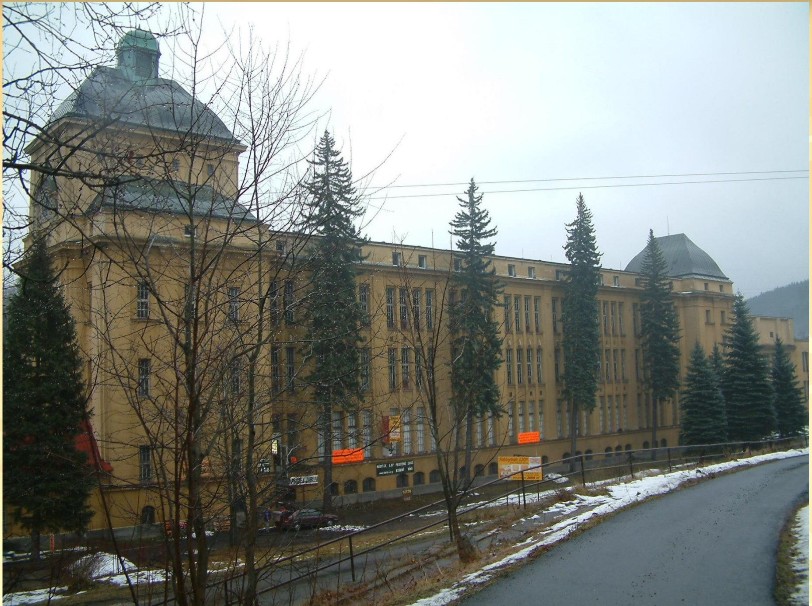
Budova bývalé budovy SEBA 06 po roce 1989 - bez využití (krátkodobé pronájmy), archiv města Smržovka 2008
